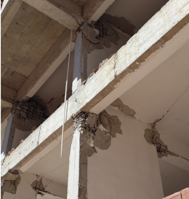
Şekil 9 • Perde ucuna bağlanan kiriş (Fotoğraf: İdris Bedirhanoğlu).
