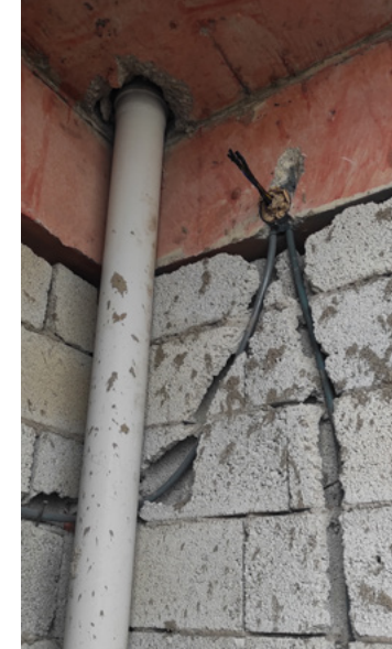
Şekil 13 • Tesisat çalışmaları için kiriş ve döşeme betonlarının kırılması ve gerekli onarımlar yapılmadan imalata devam edilmesi (Fotoğraf: İdris Bedirhanoğlu).
