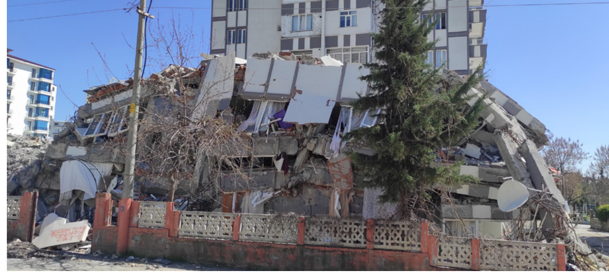
Şekil 1 • Adıyaman'da bir sitenin çöken bloğu ve ayakta kalan ağır hasarlı bloğun bodrum kat tavanı (çerçeve düzensizliği, kolon sayısı az ve kötü beton). (Fotoğraf: İdris Bedirhanoglu).
