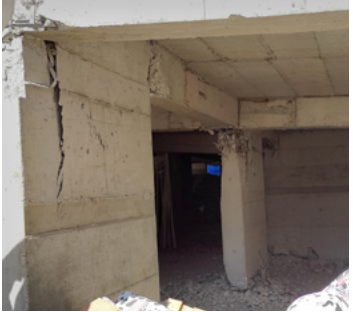
Şekil 9 • Perde ucuna bağlanan kiriş (Fotoğraf: İdris Bedirhanoğlu).
