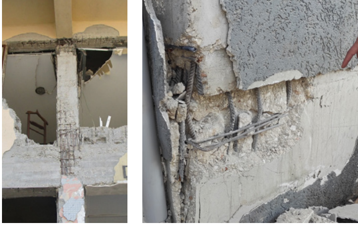
Şekil 5 • Kolon-kiriş ve kolon-temel birleşim bölgelerinde etriye olmamasından kaynaklı oluşan hasar (Fotoğraf: İdris Bedirhanoğlu).
