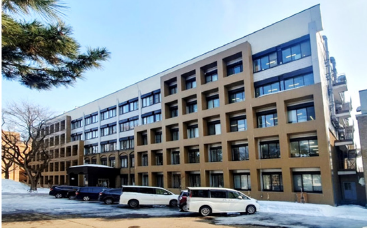
Şekil 4 • Dışarıdan çerçeve ile güçlendirme örneği (Hokkaido Üniversitesi, Fotoğraf: Fatih Sütçü).
