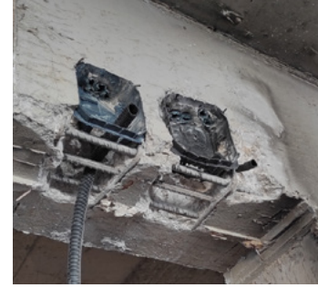
Şekil 10 • Kirişe elektrik boruları ve buati yerleştirilmiş ve duvar ile kiriş bağlantısı zayıf teşkil edilmiştir – Hatay (Fotoğraf: İdris Bedirhanoğlu).
