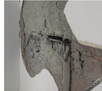
Şekil 11 • Segregasyondan dolayı betondaki büyük boşluklar – İslahiye (Fotoğraf: İdris Bedirhanoğlu).
