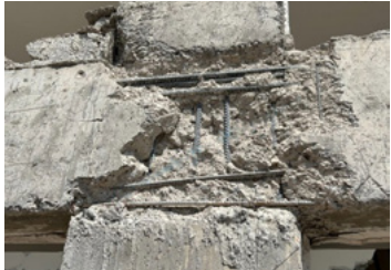
Şekil 6 • Kolon-kiriş birleşim bölgesi hasarları (Fotoğraf: İdris Bedirhanoğlu).
