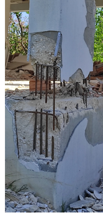
Şekil 4 • Sıyrılma kaynaklı hasarlar (Fotoğraf: İdris Bedirhanoğlu).
