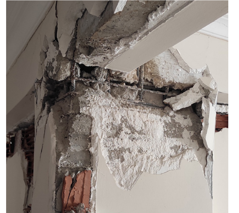
Şekil 11 • Segregasyondan dolayı betondaki büyük boşluklar – İslahiye (Fotoğraf: İdris Bedirhanoğlu).
