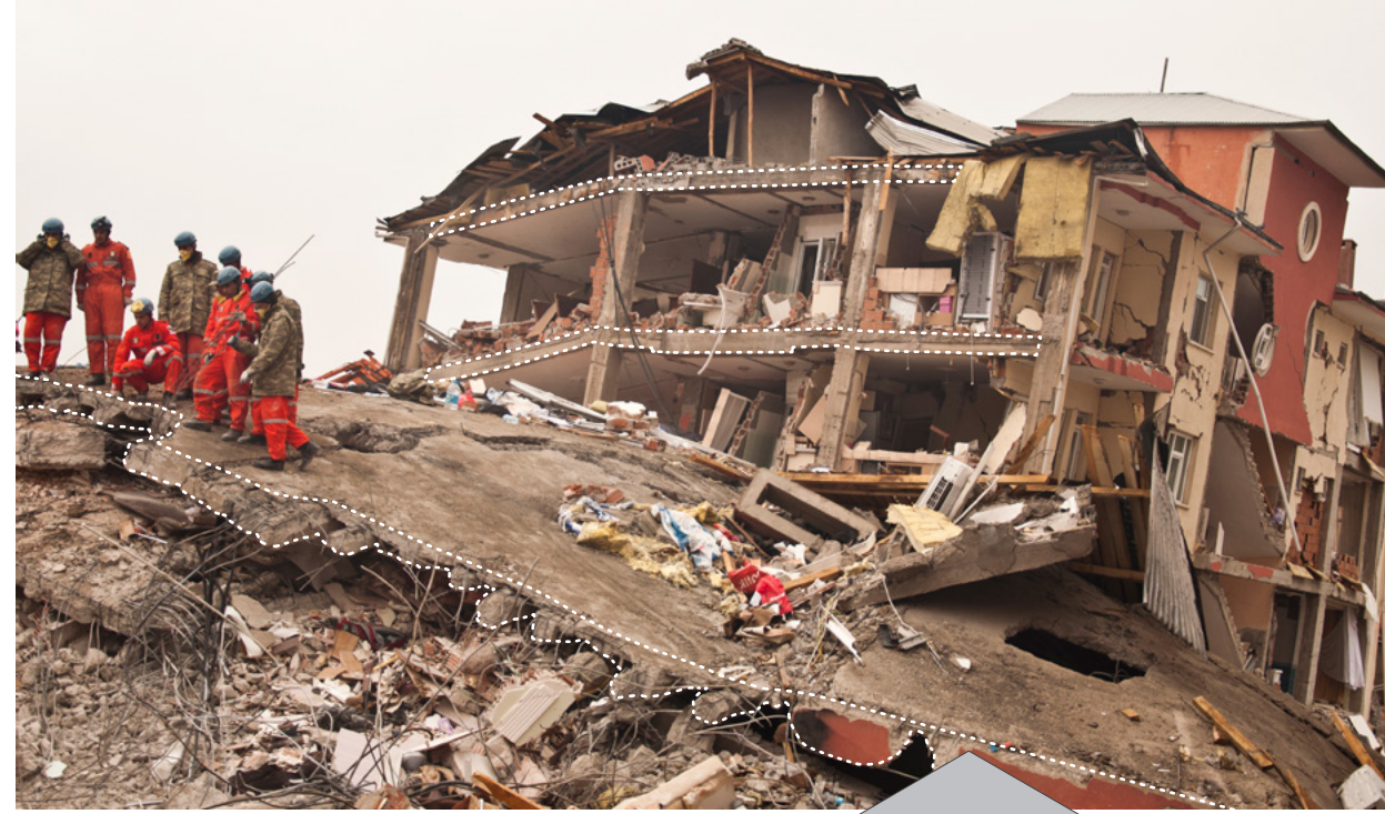
Şekil 8 • Asmolen döşeme sistemine sahip bina (Fotoğraf: 2011 Van Depremi, İdris Bedirhanoglu).
