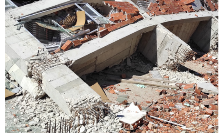
Şekil 4 • Sıyrılma kaynaklı hasarlar (Fotoğraf: İdris Bedirhanoğlu).
