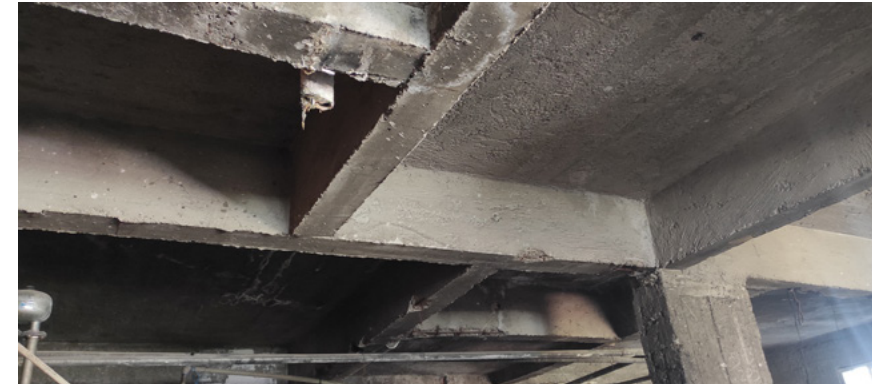
Şekil 1 • Adıyaman'da bir sitenin çöken bloğu ve ayakta kalan ağır hasarlı bloğun bodrum kat tavanı (çerçeve düzensizliği, kolon sayısı az ve kötü beton). (Fotoğraf: İdris Bedirhanoglu).
