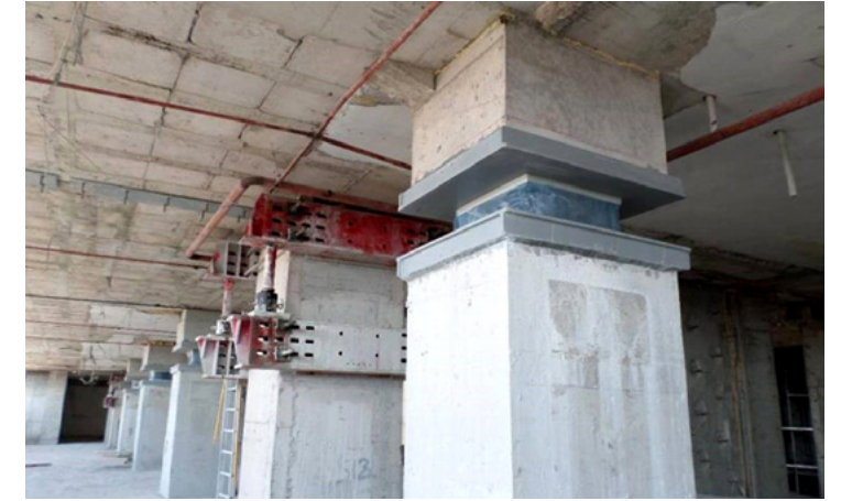
Şekil 7 • Sismik izolasyon ile güçlendirmede izolatör montajı (Fotoğraf: Rasih Turan).
