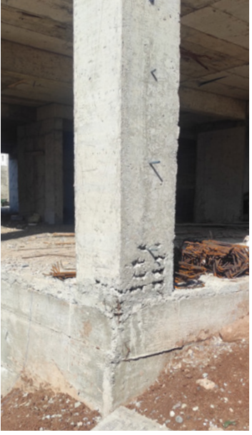
Şekil 14 • Kolonun temel kenarına sıfır bir şekilde bağlanması (Fotoğraf: İdris Bedirhanoğlu).
