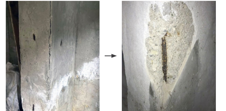
Şekil 10 • Bodrum katlarda sıkça görülen korozyon hasarı (Fotoğraf: Fatih Sütçü).
